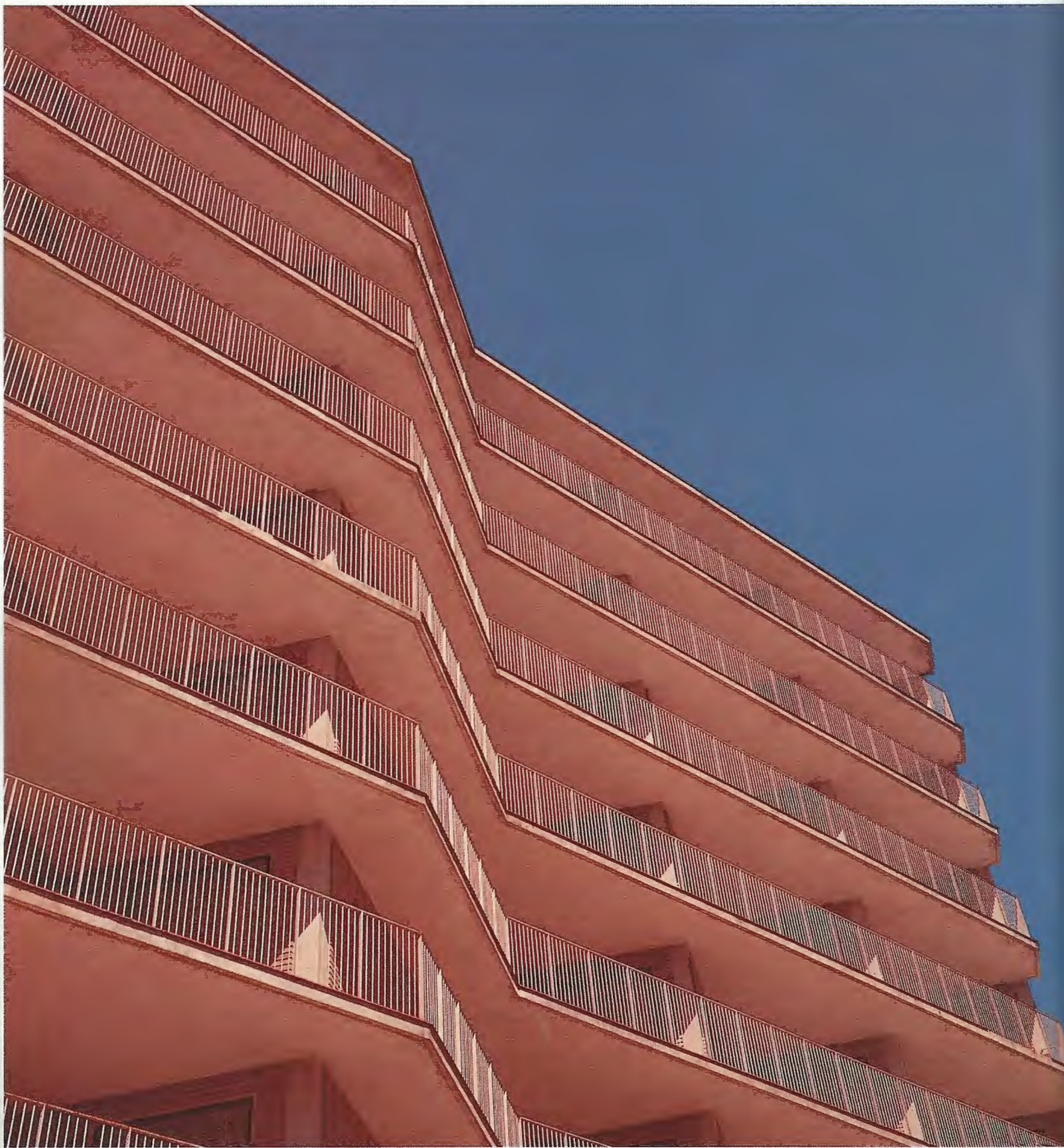
Colegio Mayor Aquinas Rafael de La-Hoz y José María García de Paredes
